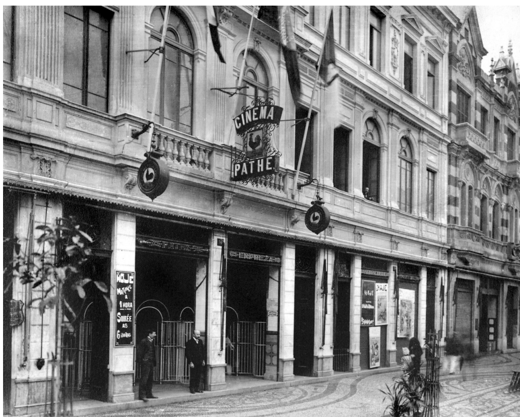
Aspecto da fachada do cinema Pathé, na avenida Central, na época de sua inauguração, fotografia de Marc Ferrez, 1907
