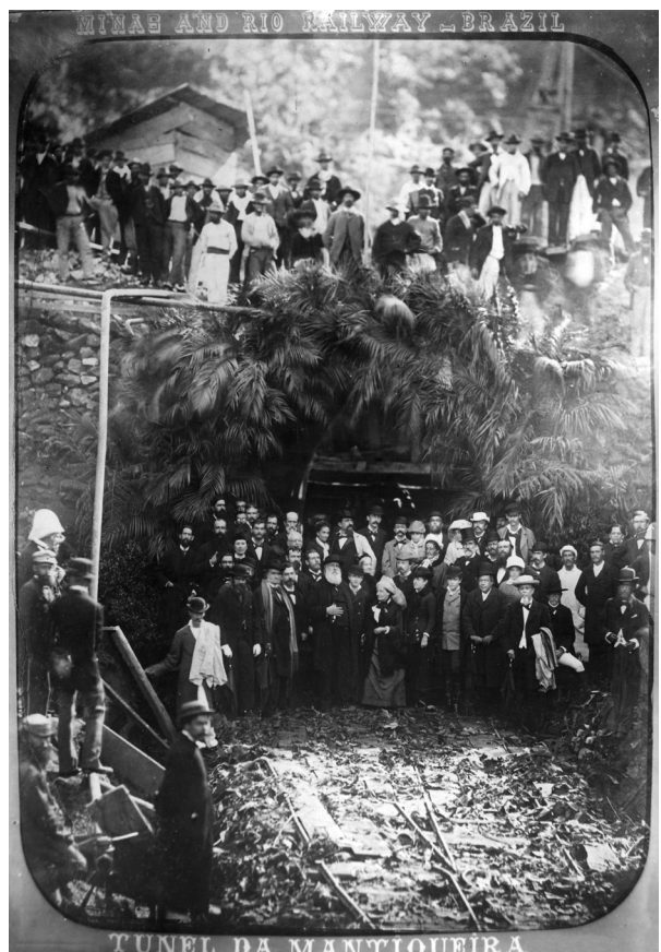
Imperador Pedro II e outros visitam o túnel da Mantiqueira das Minas and Rio Railway, fotografia de Marc Ferrez, 1882
